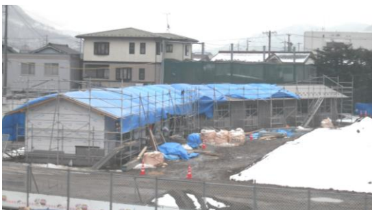
校庭東に建築中の部室・外倉庫・外トイレ棟
